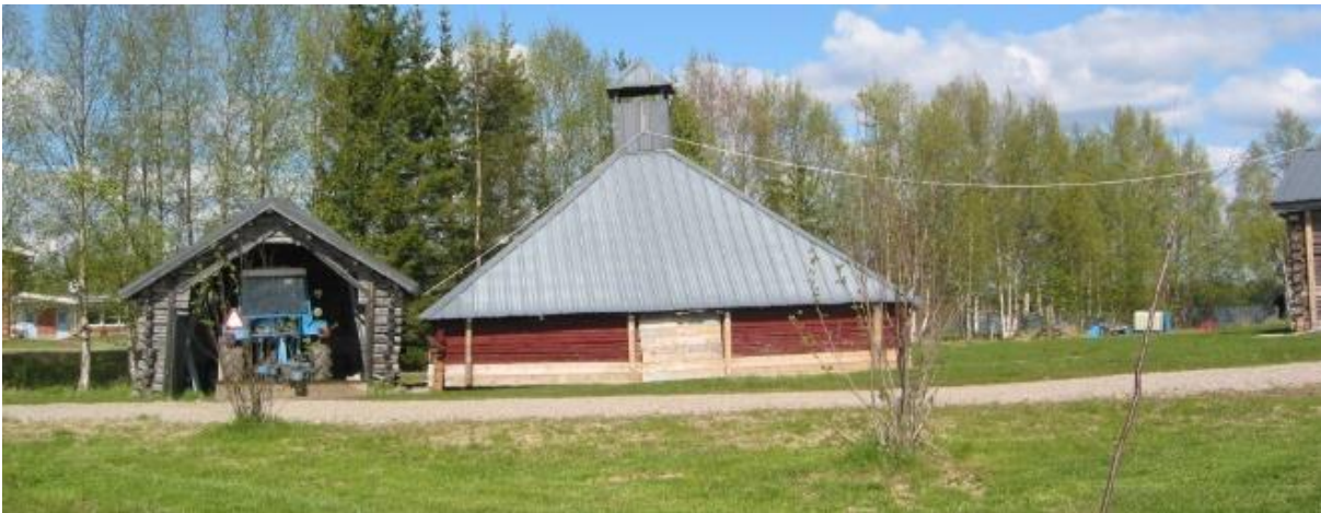
Kuva 18. Ranuan Pappilanniemiessä Rantatien varrella on perinteinen pyramidikattoinen navettarakennus. Rakennusta on kunnostettu, mm. katto on uusittu. (Kuva vuodelta 2004).
