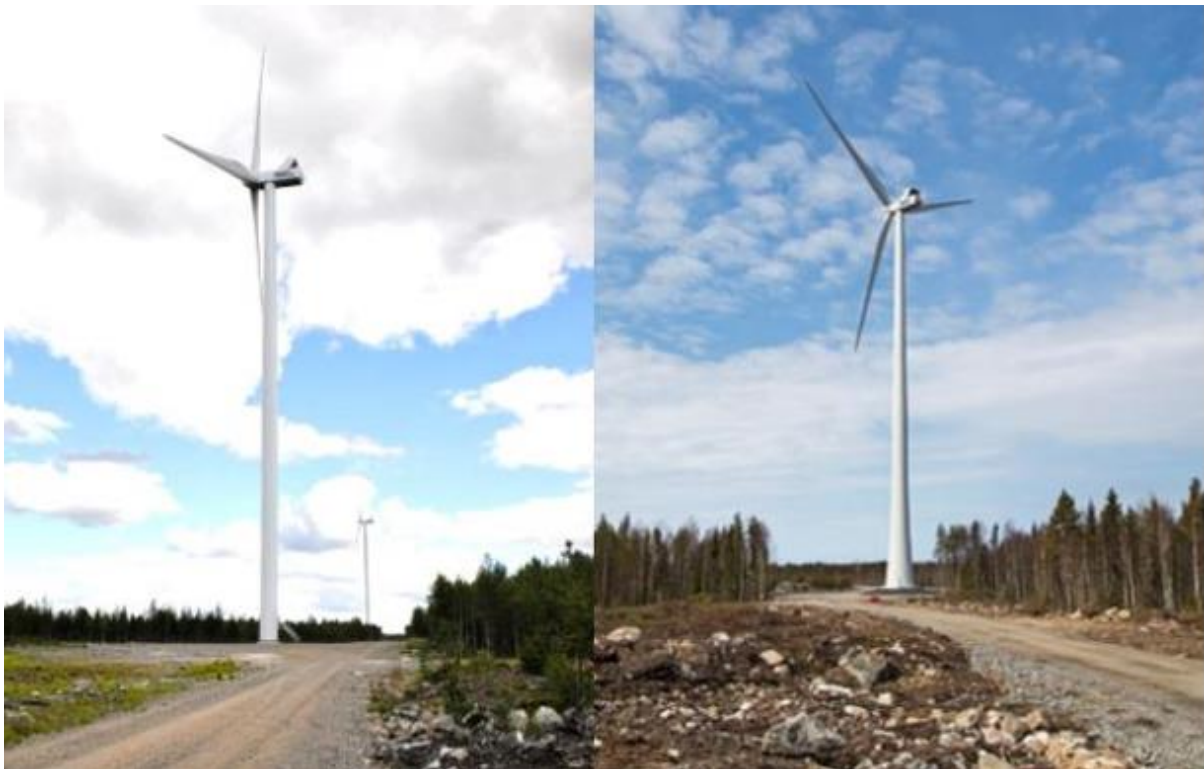
Kuva 6. Vasemmalla on esimerkki teräslieriötornista ja oikealla hybriditornista. (Kuvat: FCG)
